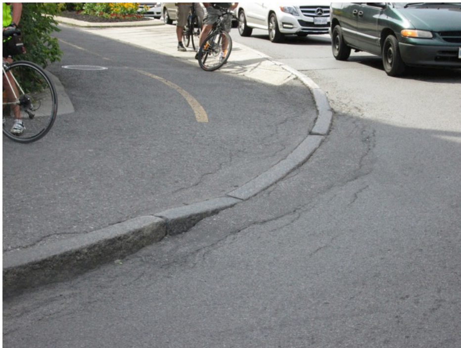
Photo 1b. Vue en direction ouest. Angle de la descente du trottoir ne correspond pas à la direction de l'îlot de transition vers la piste cyclable.
