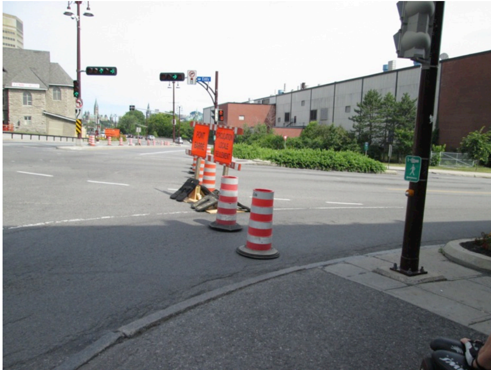
Photo 1a. Vue en direction est. Angle de la descente du trottoir ne correspond pas à la direction de la piste cyclable vers l'îlot de transition (derrière les pilonnes).
